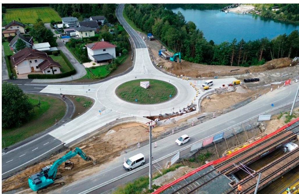
Der neu errichtete Kreisverkehr in Föderlach aus der Vogelperspektive
