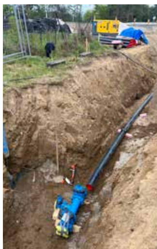
Das Wasserleitungsnetz wird laufend saniert.
