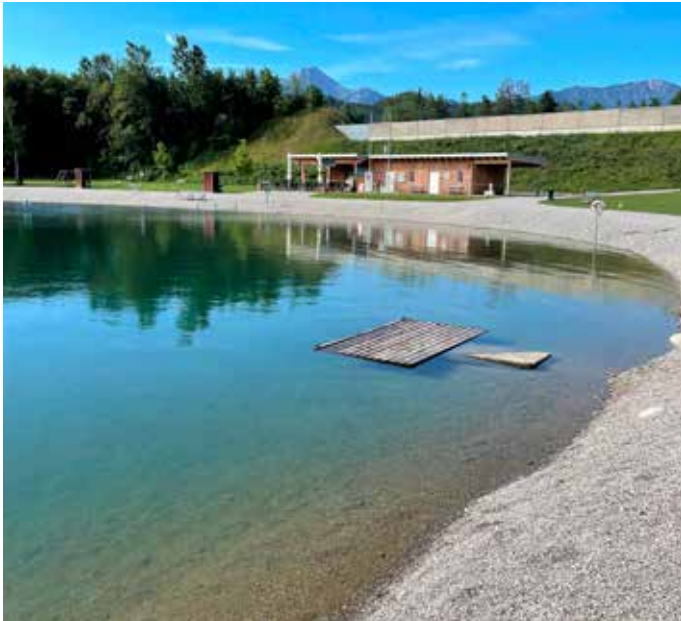
Das Freibad Wernberg wird heuer umfassend modernisiert.
