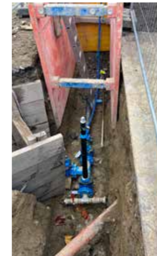
Im Frühjahr wird die Generalsanierung des Amselwegs abgeschlossen.
