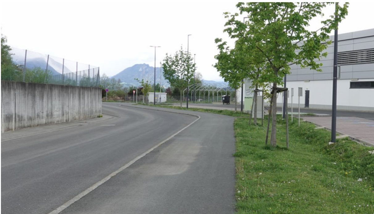
Foto 6: Handelsweg mit Geh-/Radweg und angrenzend Bepflanzung
